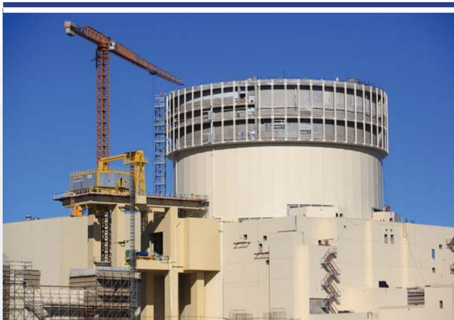
которые имели место на АЭС «Фукусима». Также проектом предусмотрена двойная защитная оболочка здания реактора — внутренняя и наружная. В случае аварии первая предотвратит выход радиоактивных веществ в окружающую среду, а вторая послужит физической защитой от природных и техногенных внешних воздействий, включая землетрясения, ураганы и падение самолета.
