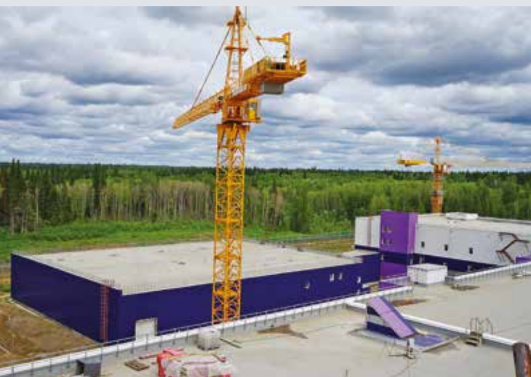
Строительная площадка проекта «Прорыв» (АО «СХК», г. Северск)
